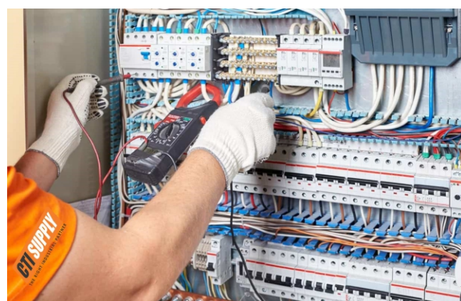
CUNG CẤP VÀ LẮP ĐẶT HỆ THỐNG ĐIỆN 提供与安装电力系统
