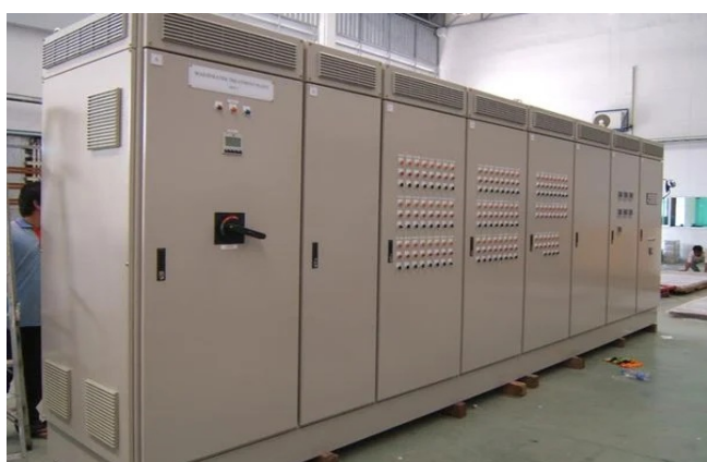
CUNG CẤP VÀ LẮP ĐẶT TỦ PHÂN PHỐI ĐIỆN 提供与安装电力配电柜
