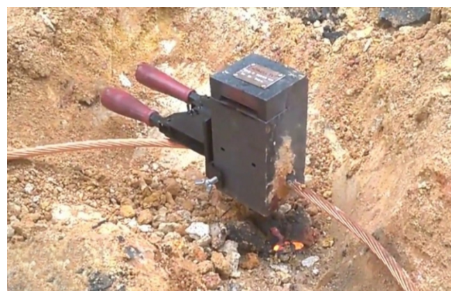
CUNG CẤP VÀ LẮP ĐẶT HỆ THỐNG TIẾP ĐỊA CHỐNG SÉT 提供与安装防雷接地系统
