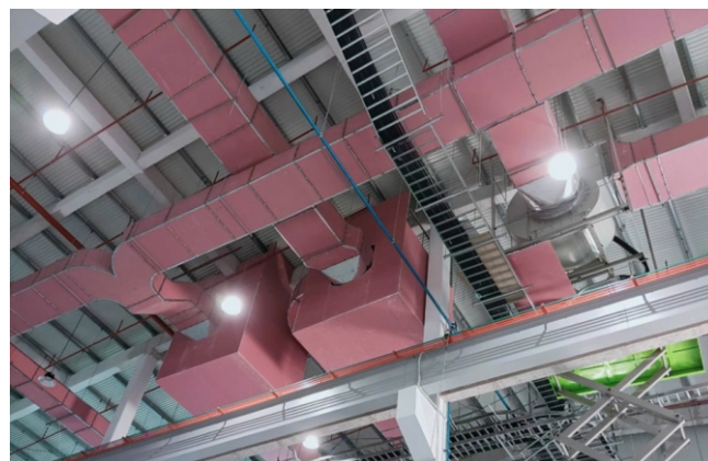
CUNG CẤP VÀ LẮP ĐẶT HỆ THỐNG CHỮA CHÁY 提供与安装消防系统
