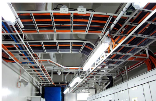
CUNG CẤP VÀ LẮP ĐẶT HỆ THỐNG CHIẾU SÁNG 提供与安装照明系统
