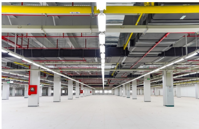
CUNG CẤP VÀ LẮP ĐẶT HỆ THỐNG THÔNG GIÓ VÀ ĐIỀU HÒA KHÔNG KHÍ 提供与安装通风与空调系统
