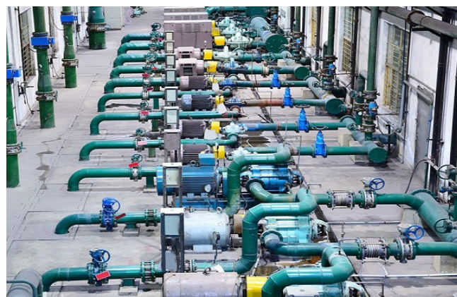
CUNG CẤP VÀ LẮP ĐẶT HỆ THỐNG CẤP THOÁT NƯỚC 提供与安装给排水系统
